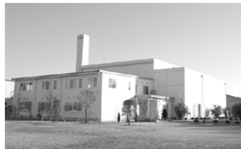
高温ガス炉燃料製造建屋
