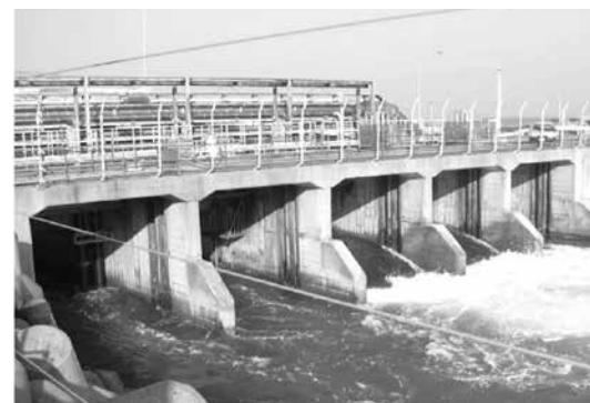
写真1 発電所放水口
