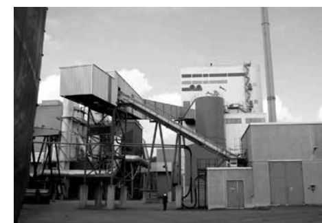
写真2 サンドヴィックIIプラントの外観
