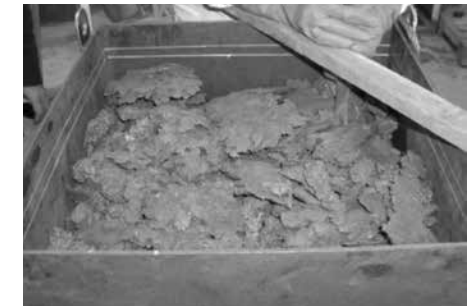
写真8 モルタル充てん前の状況
