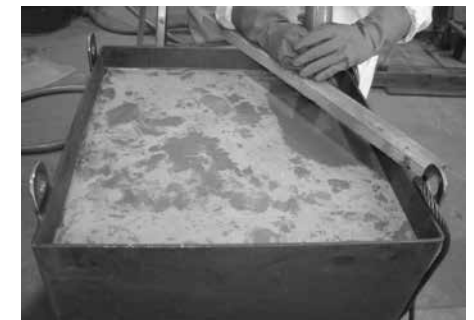
写真9 モルタル充てん終了後の状況
