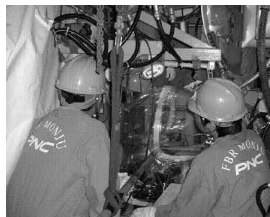
写真4 現地工事の様子（シールバッグ）
