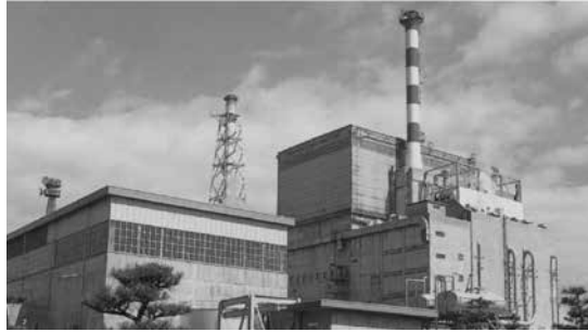
図1 日本原子力発電(株) 東海発電所
