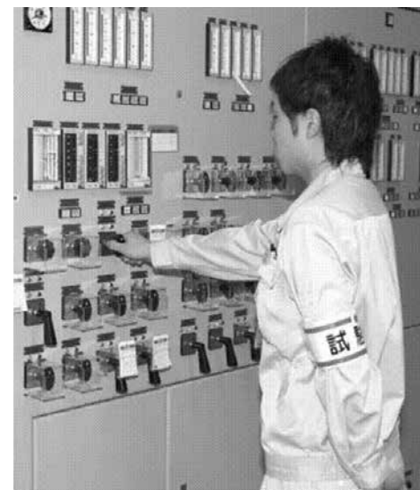
写真1 炉外燃料貯蔵設備 弁開閉試験の様子
