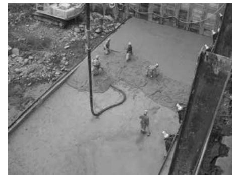
写真3 ラップルコンクリートの打込み状況
