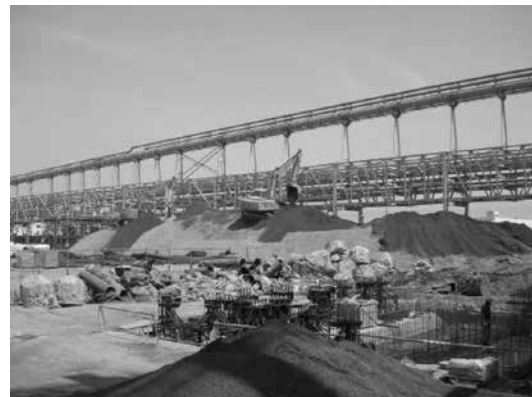
解体コンクリート塊の野積み保管
