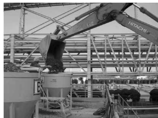
解体コンクリート塊の計量
