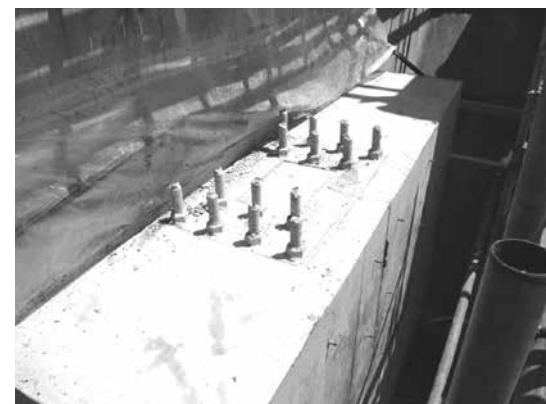
写真6 ジャッキ架台基礎(コンクリート打設後)
