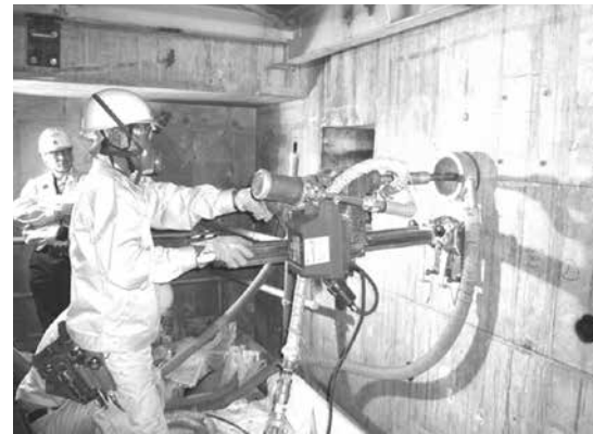
写真2 コアボーリングによるワイヤ貫通穴空け作業
