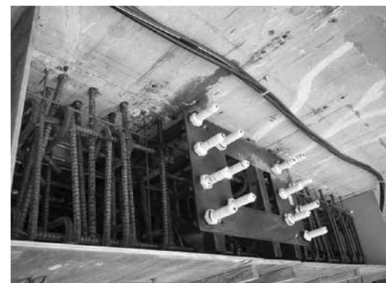
写真5 ジャッキ架台基礎(ケミカルアンカ据付)
