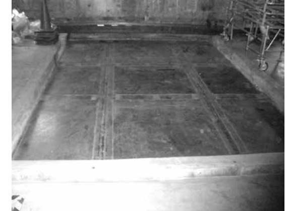
写真9 ステージ施工
