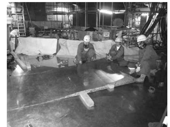
写真10 ステンレス鋼板施工
