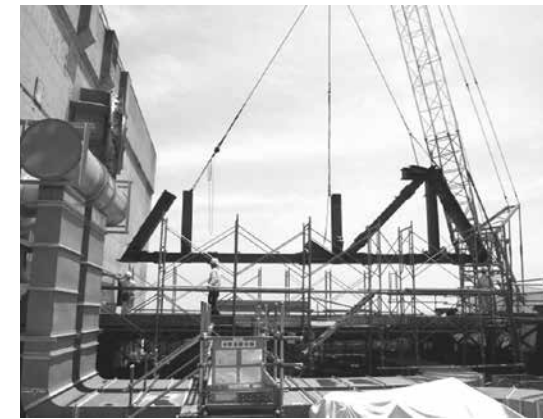
写真7 ジャッキ架台設置
