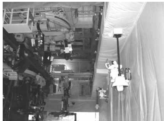
写真13 難燃性シート養生
