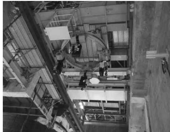
写真11 遠隔把持搬送装置据付
