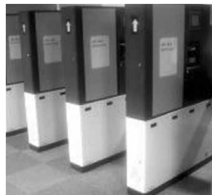
写真1 管理区域入域ゲート外観
