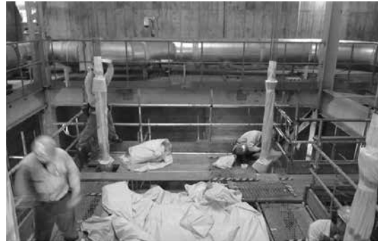
写真10 バリア設置工事
