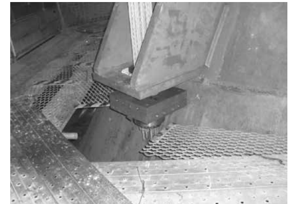
写真8 上部アンカへのストランド接続
