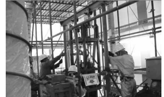
写真7 ジャッキ移設作業
