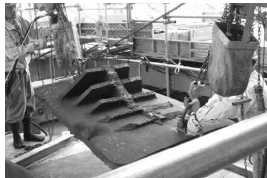
写真1 振止金具撤出作業
