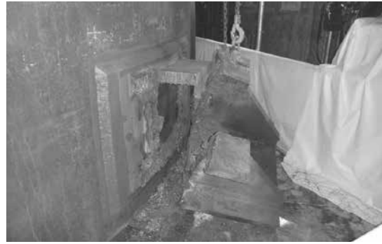
写真9 下部アンカ取り外し作業
