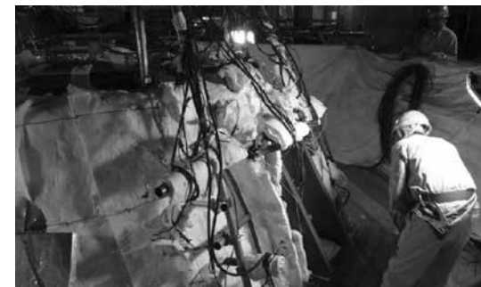
写真4 上部アンカ焼鈍作業
