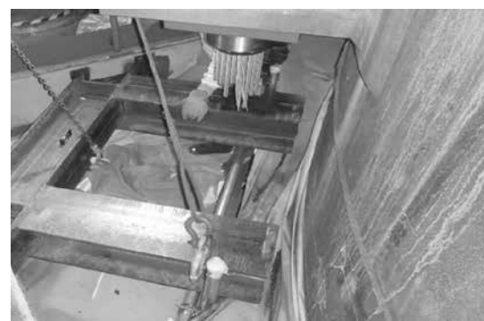
写真2 倒れ止め金具の設置
