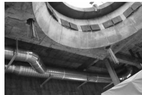
写真6 ストランド巻上作業
