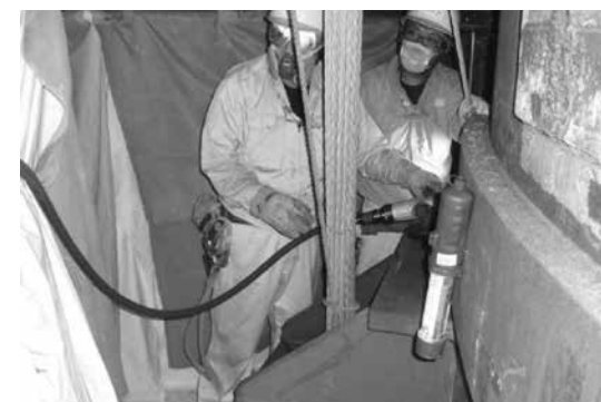
写真5 下部アンカからのストランド取り外し作業
