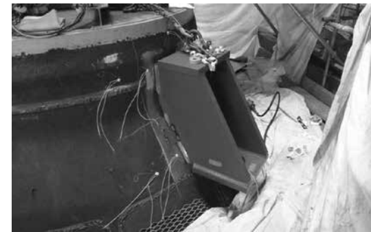
写真3 上部アンカの溶接施工
