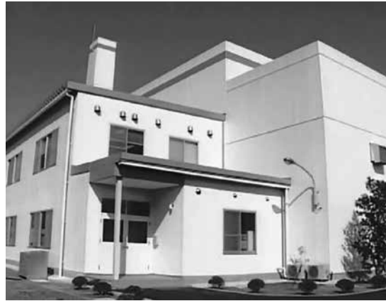
写真1 商用規模の燃料製造施設
