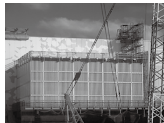
2号機の状況 (ブローアウトパネルにより閉止完了)
