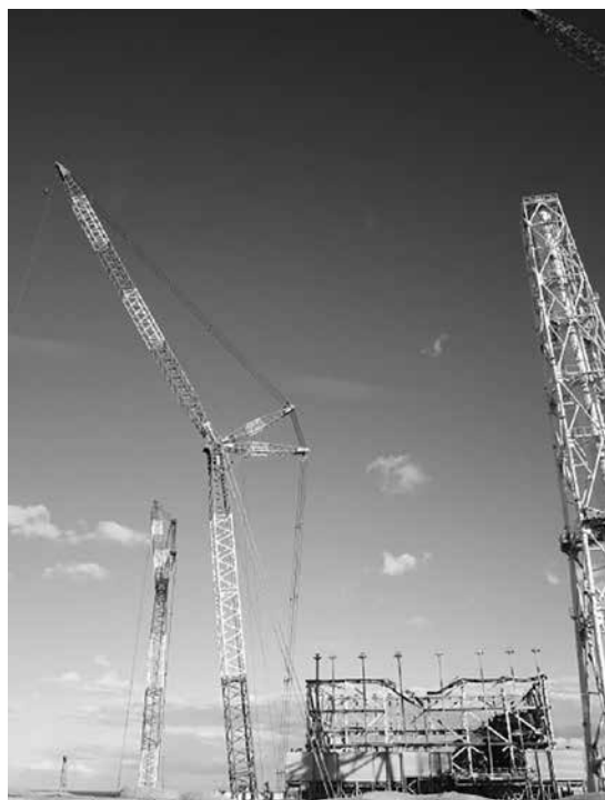
1号機と解体中の排気塔
