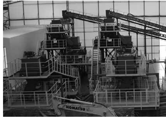
写真2 CSSの全景 (70t/h×2基)
