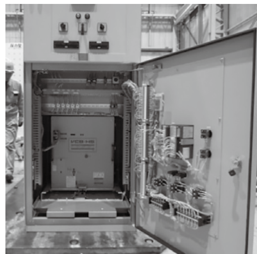
図4 高圧配電盤内機器取付状況
